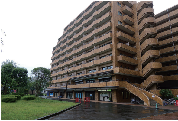
1987 年竣工、今年で築 30 年を迎える朝日プラザ柏木。鉄骨鉄筋コンクリート・鉄筋コンクリート造の建物の 1 階には 10 の店舗も入る。住戸タイプは 30 以上と豊富で、ファミリー層から子どもが巣立った高齢者まで多様な人々が居を構えている
